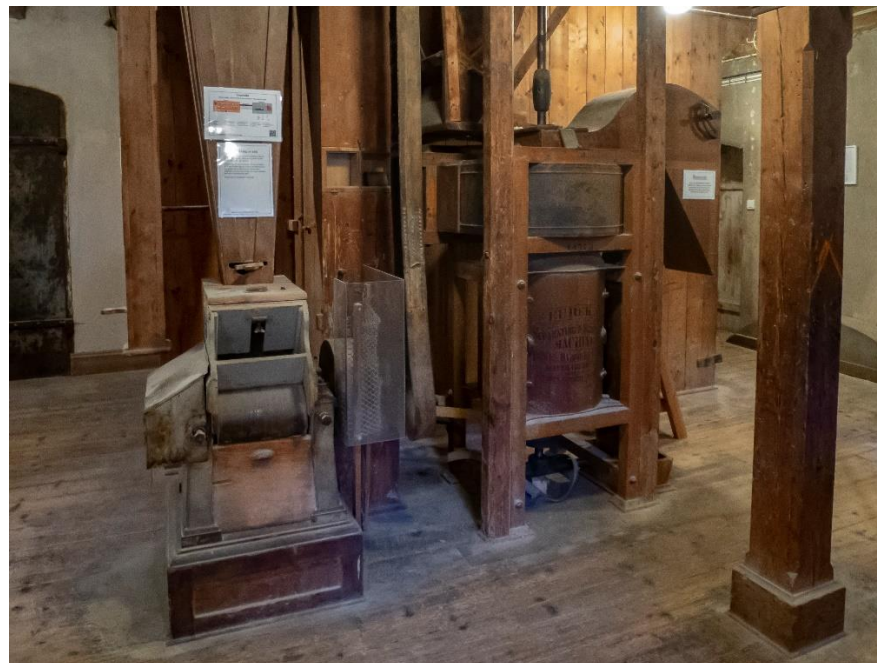
Rensverket på mellanvåningen, rensmaskin till höger och klämvalsstol till vänster. Elevatorerna står mellan maskinerna.
