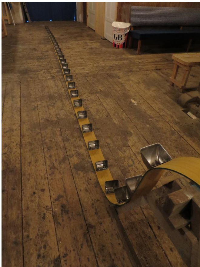
Elevatorremmen med skoporna innan monteringen i trummorna.
