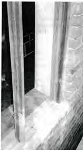
Kvarnfönstren har fått nya bottenstycken.
